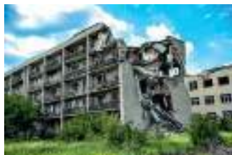
Іл. 44.11. Руїнування будівлі внаслідок обстрілу
