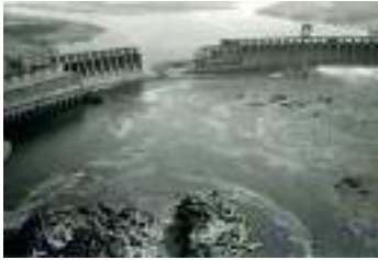
Іл. 42.8. Зруйнована вибухом гребля Дніпрогесу в 1941 р.
