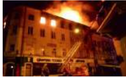
Іл. 43.5. Пожежа в центрі Тернополя в 2015 р.
