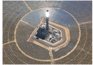
Рис. 10. Одна з найбільших сонячних електростанцій у світі — «Айванпа» (США, Каліфорнія). 173 тис. дзеркал відбивають сонячне світло та спрямовують його на вершини трьох веж, де встановлено котли з водою. Гаряча пара надходить на лопаті турбін, установлених усередині веж
