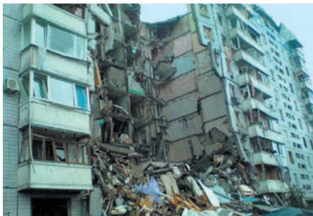
Мал. 23.5. Наслідки вибуху природного газу в багатоповерховому житловому будинку, 13 жовтня 2007 року, м. Дніпро
